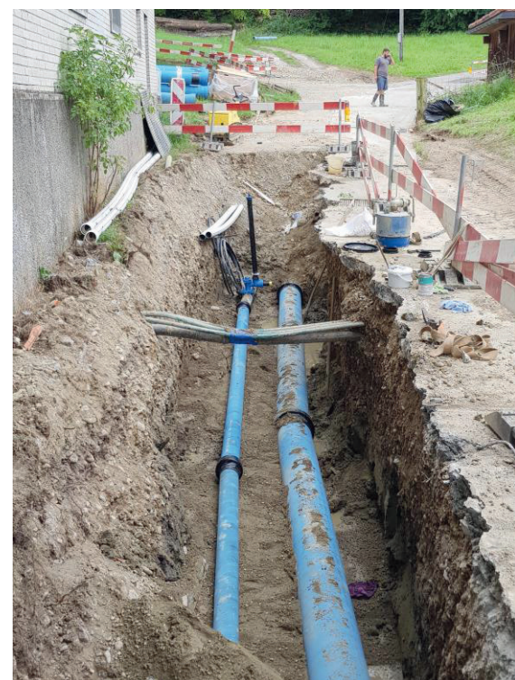
Leitungsbau in Schwanden
