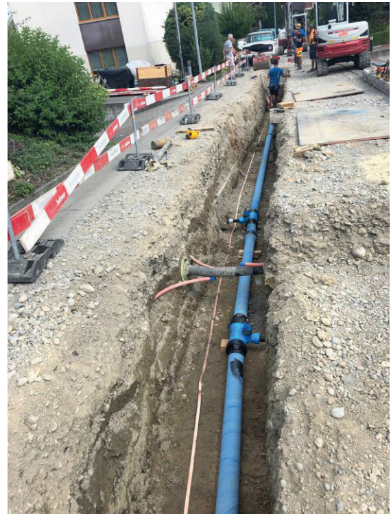
Leitungsersatz Rapperswil Rossgartenstrasse
