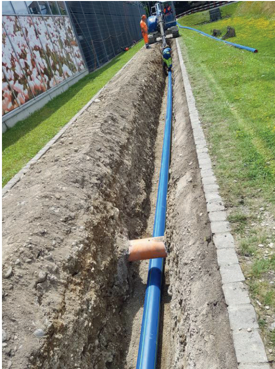
Leitungsbau Moosseedorf OBI Nord/Süd
